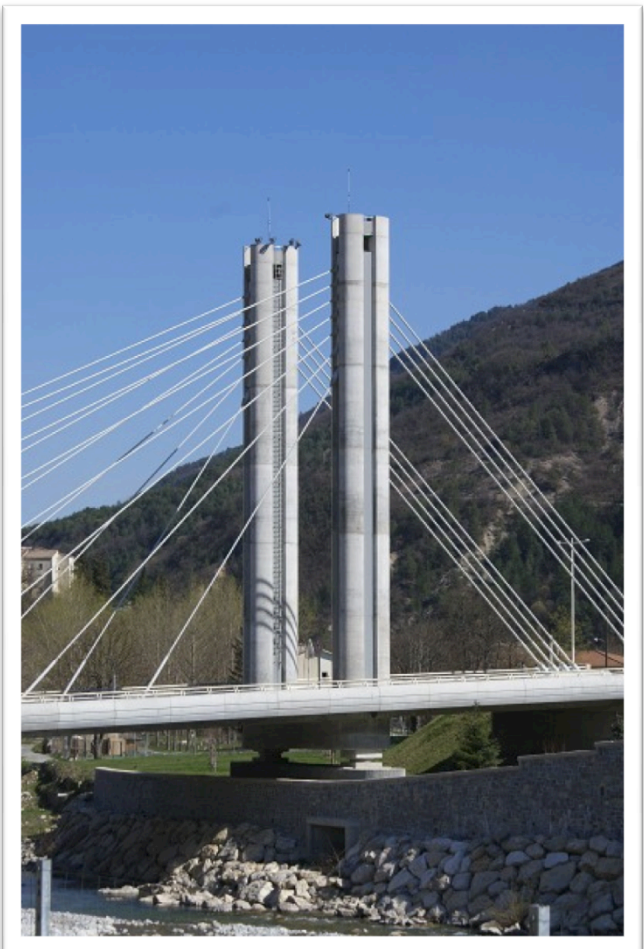
Pont à haubans asymétrique de Puget-Thenier
